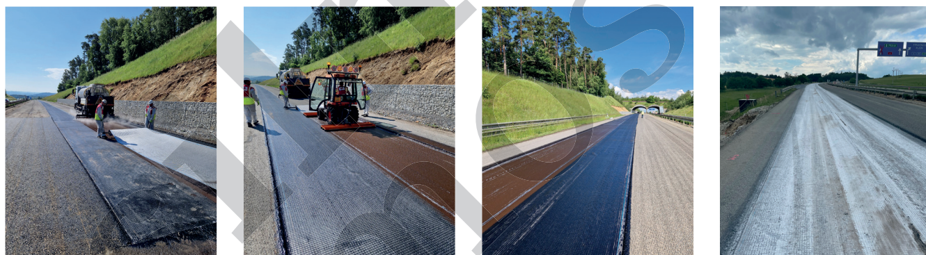
Obrázek 1: Realizace geokompozitu na stavbě dálničního typu
