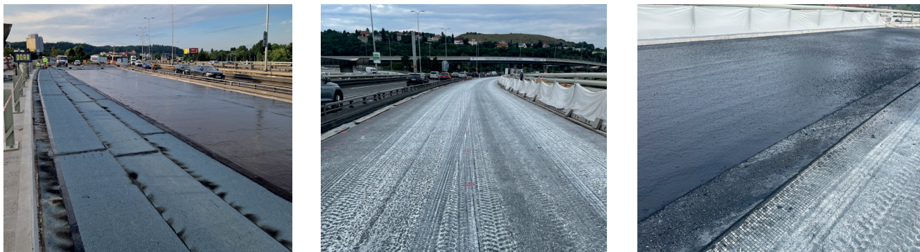
Obrázek 2: Průběh prací: aplikace KAE, ochranného postřiku a litého asfaltu na mostě
