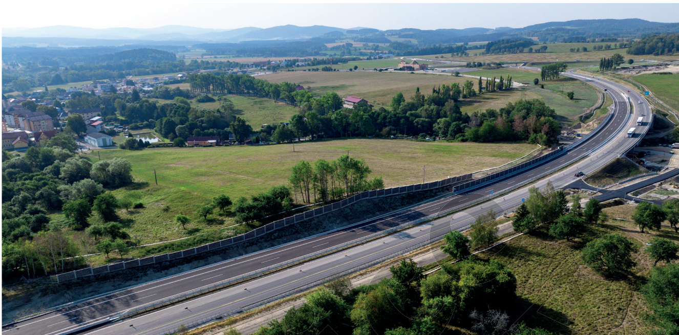
Obrázek 2: Na trase bylo vybudováno celkem 632 m protihlukových stěn
