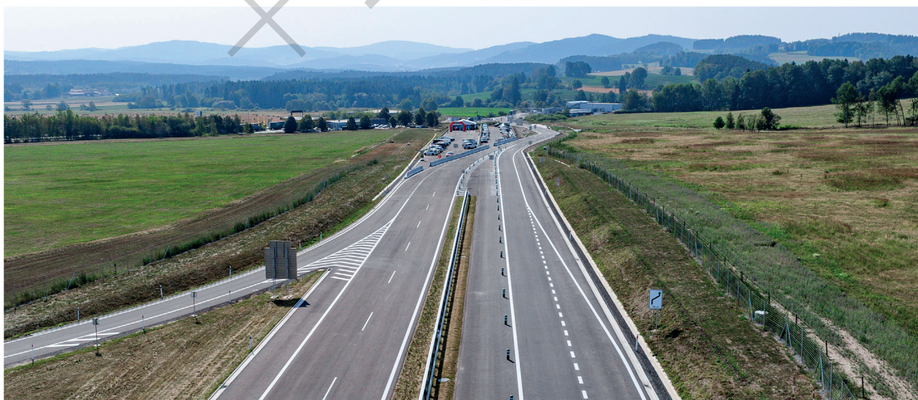
Obrázek 4: Stavba spojující Českou republiku s Rakouskem byla uvedena do provozu o měsíc dříve, 31. července 2026
