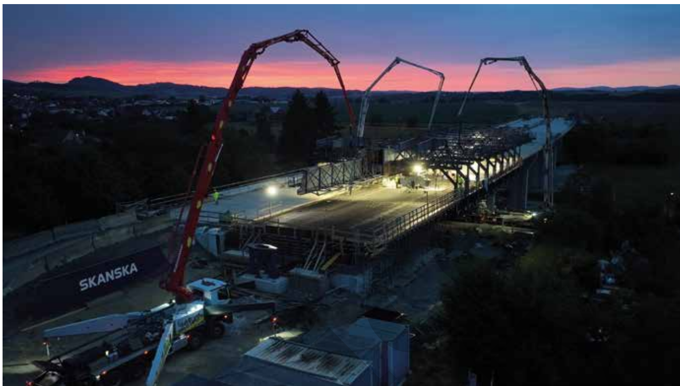
Obrázek 5: SO 225 – poslední betonáž
