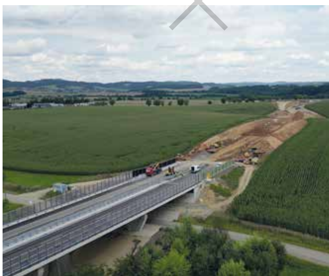
Obrázek 6: Fotografie hotové dálnice a nedokončeného napojení na II/490
